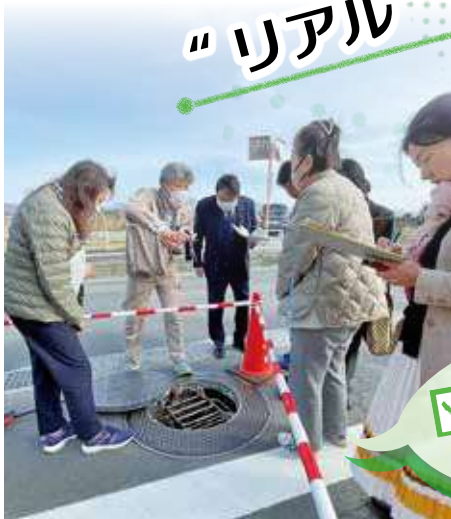
ぐみの木マンホールポンプと 引込計器盤更新工事
