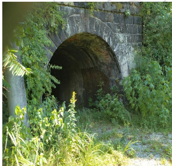
箱根第5号隧道
