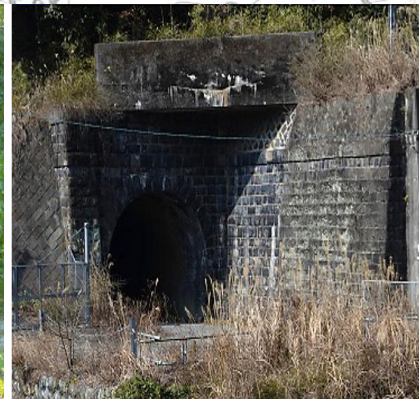
箱根第2号隧道
