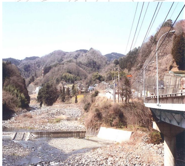
第1相沢川橋橋梁
