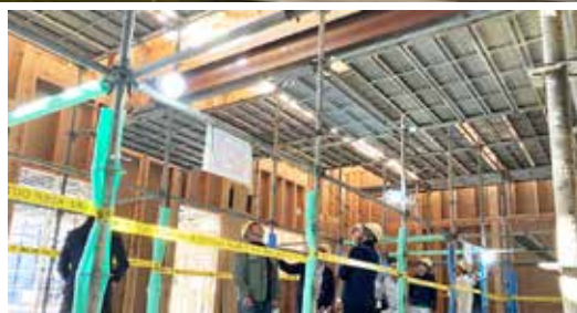
建設中の生涯スポーツセンター 見学会の様子
