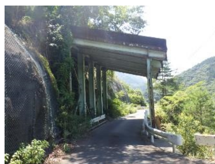
神縄第一洞門
