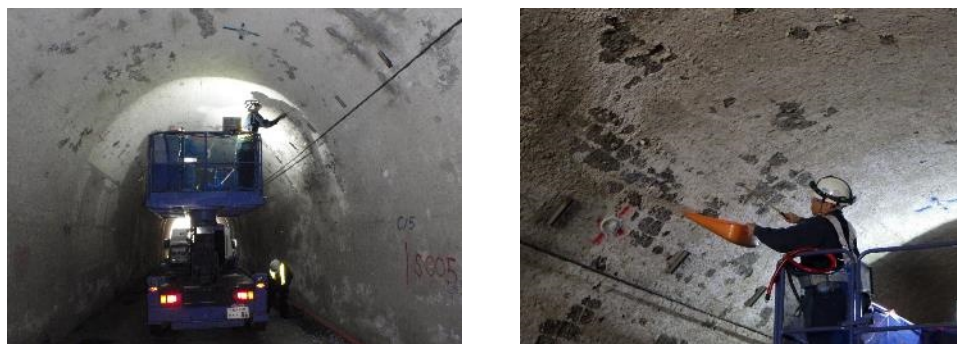
写真 5 - 1 点検実施状況
