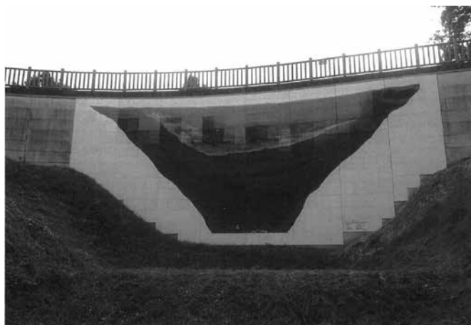
全体で94㎡ 360枚のタイルを張り付けました
