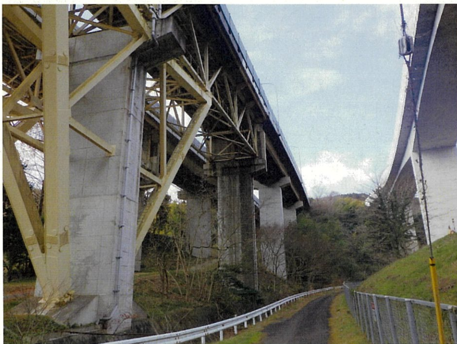
<写真 通行止めする向原の道路と東名高速道路滝沢川橋>
