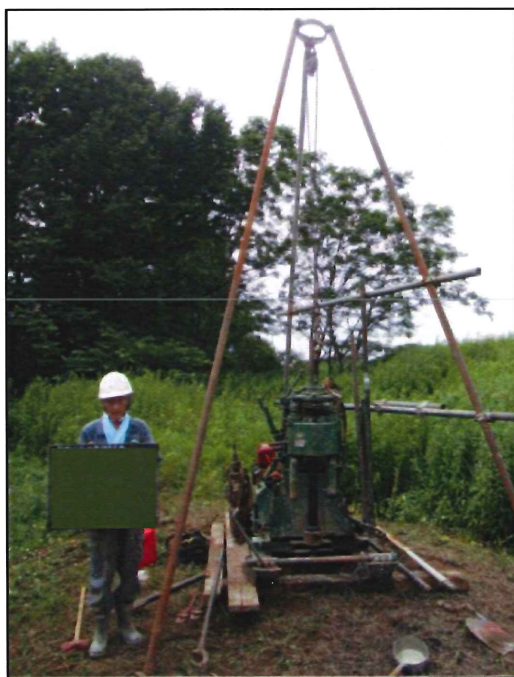
ボーリング調査の例
