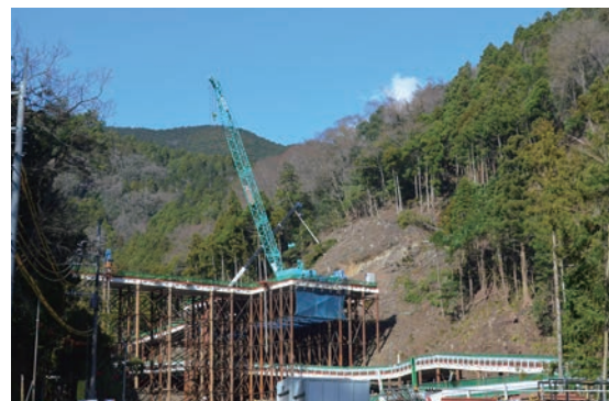
高松トンネル工事区より高松山
