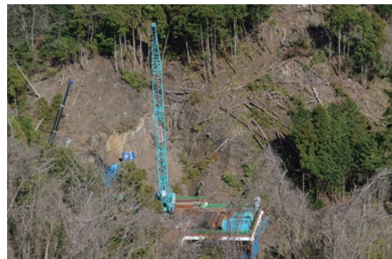
高松トンネル工事区
