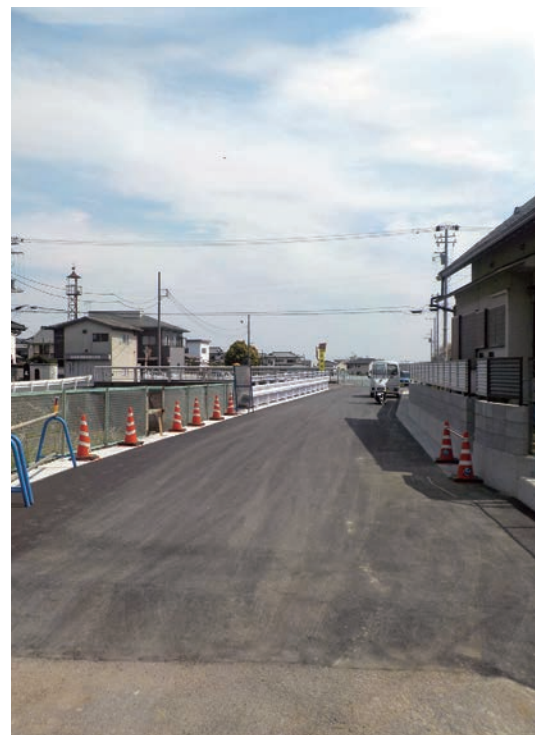
整備が進む町道水上2号線
