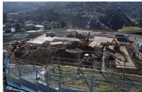
湯触トンネル工事区
