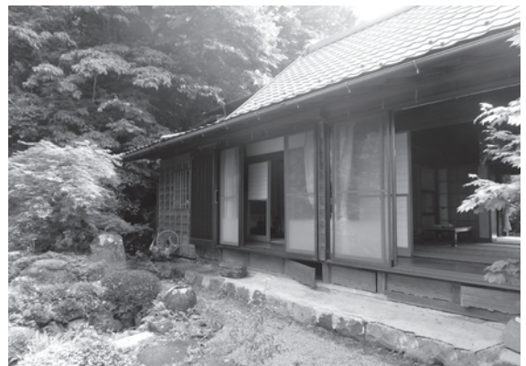
平成28年度にオープンしたお試し住宅「ホタルの家」
