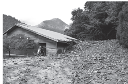
土砂に埋まった中川水源交流の里施設
