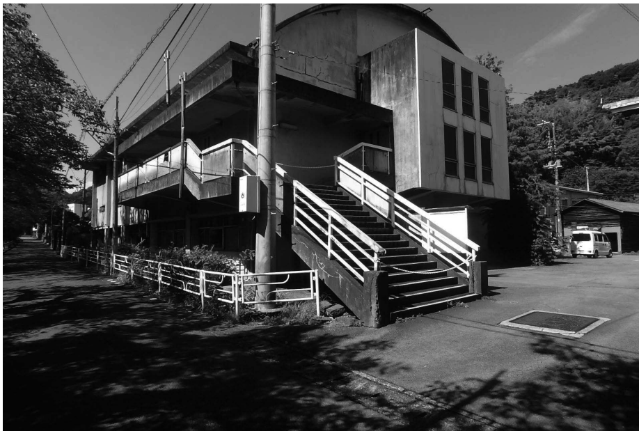
(解体前の山北体育館)
