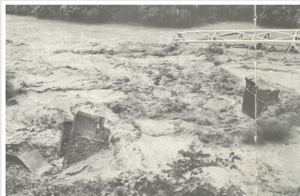
▲ 橋が流失した御殿場線「第3酒匂川鉄橋」
