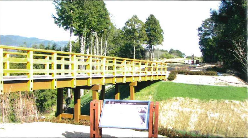
本城郭から見た木橋と蔵郭の整備
