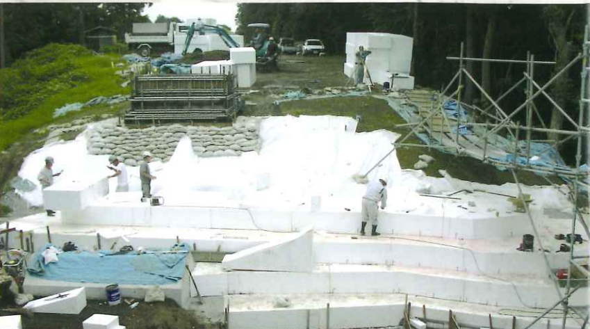
蔵郭側の軽量盛土（発泡スチロール組立）
