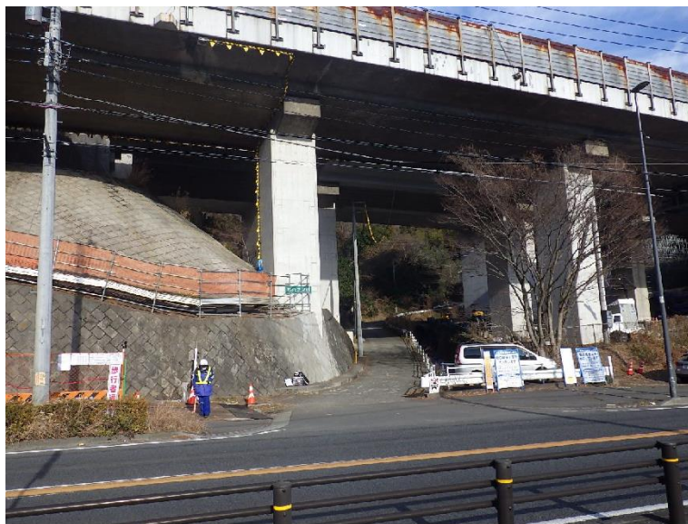
<写真 通行止めする鳶ノ子沢の道路と東名鳶ノ子沢橋>
