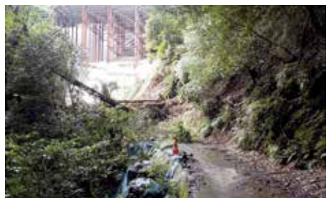
被災箇所（滝沢林道）
