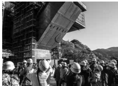
河内川橋工事では、アーチ部分を伸ばし始めている橋脚などを見学しました。
