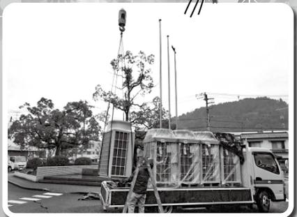
新しい室外機にロープを取り付けます
