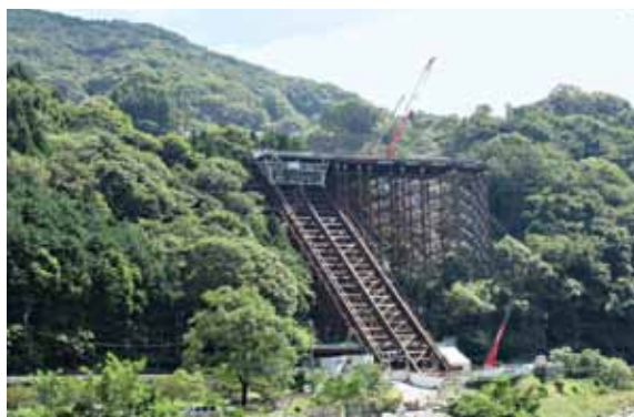
河内川横断橋建設インクライン
