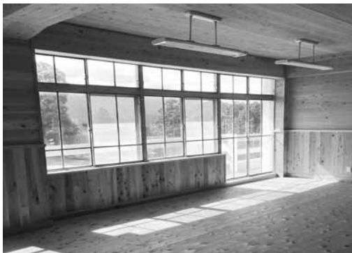
町内の木材を利用し木質化された共和のもりセンター
