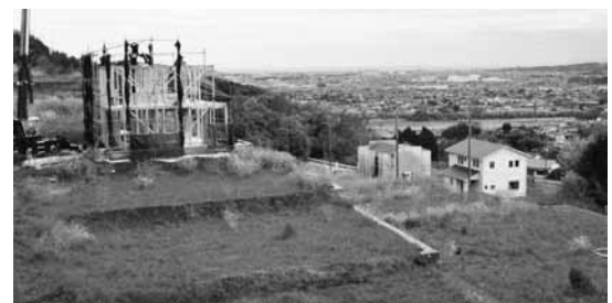
建築が進むヒルズタウン丸山
