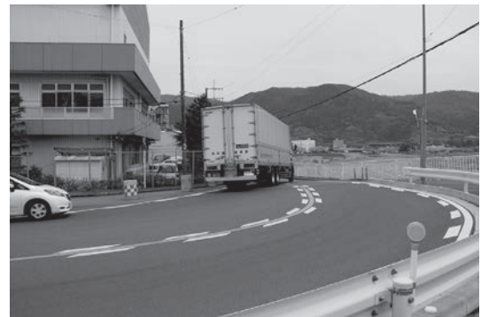
拡幅工事を待つ三菱ガス化学(株)付近
