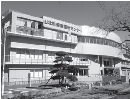
健康福祉センターは、町内外から多くのスポーツ愛好家が訪れる注目のスポット
