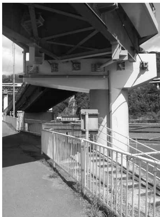
インフラ長寿命化計画により 予防措置として改修中の谷ヶ跨線橋
