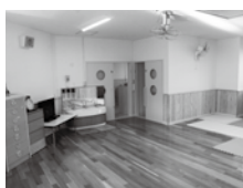
改修中の園舎の様子(わかば保育園)
