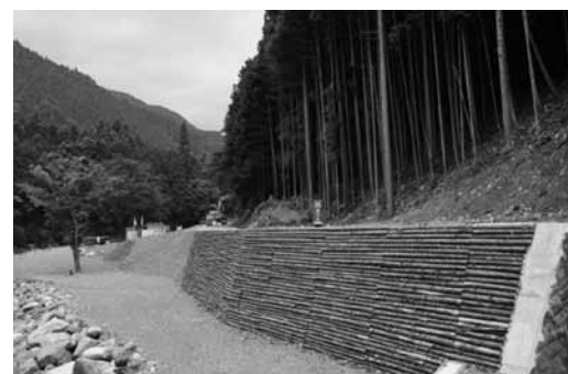
完成間近い水の木幹線林道
