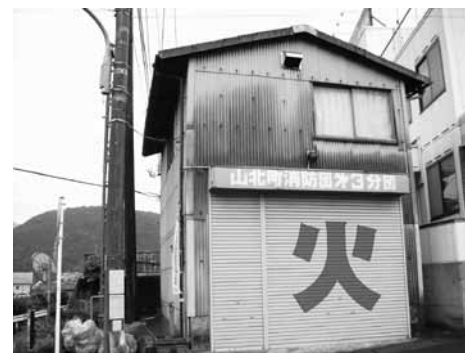
重要拠点となる消防分団詰所
