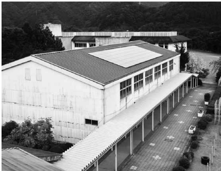
旧三保中学校体育館に設置されたソーラーパネル
