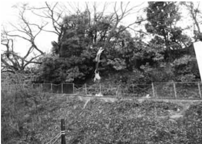
大雪による倒木とフェンスの破損
