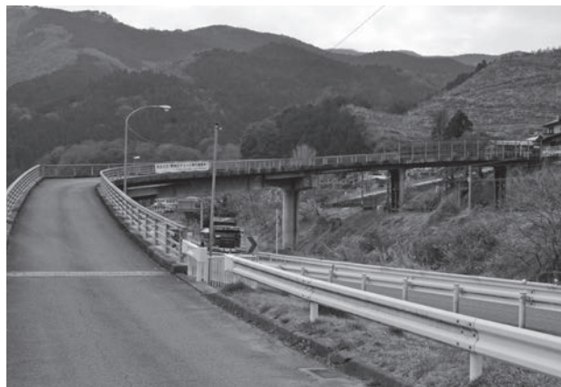
補強工事を行う谷ヶ跨線橋
