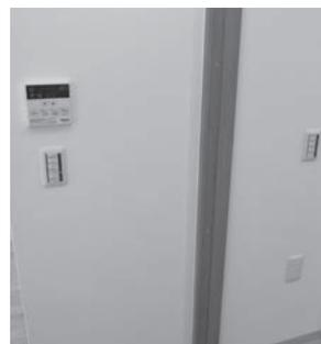
スイッチ類は低い位置で子どもにも操作しやすく、コンセントは高い位置でペットのいたずらによる漏電を防ぐ
