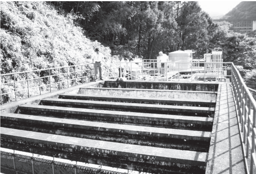
おいしい水をつくる皆瀬川浄水場
