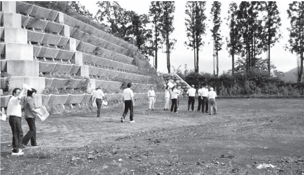
絶景の富士に見とれて(建設中のつぶらの公園)
