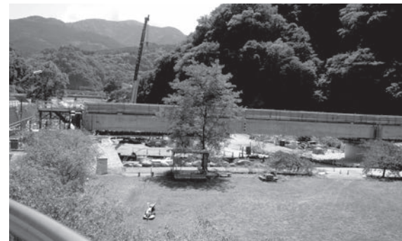
建設中の新塩沢橋
