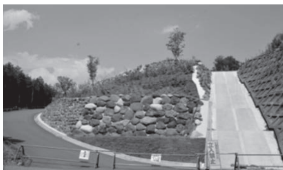
工事中の県立つぶらの都市公園
