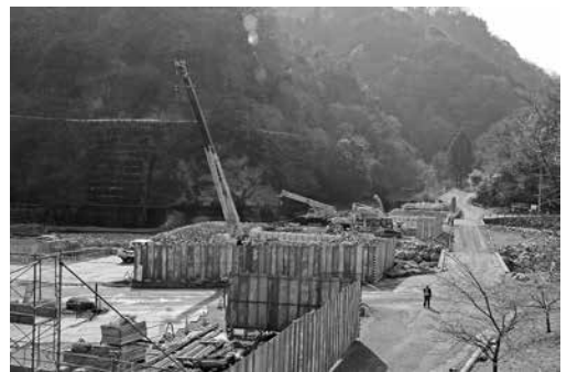
(仮称) 新塩沢橋の建設工事
