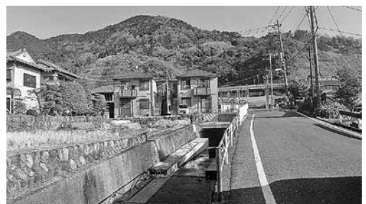
水路を改修し道路拡幅を行う町道中里松原先線
