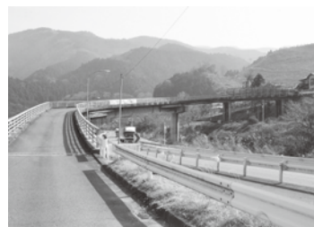
耐震診断を行う谷峨跨線橋
