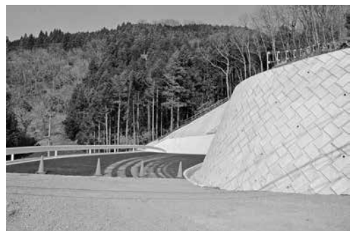
町道嵐線の整備工事
