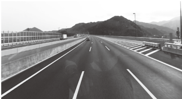
4月14日に開通した新東名高速道路
