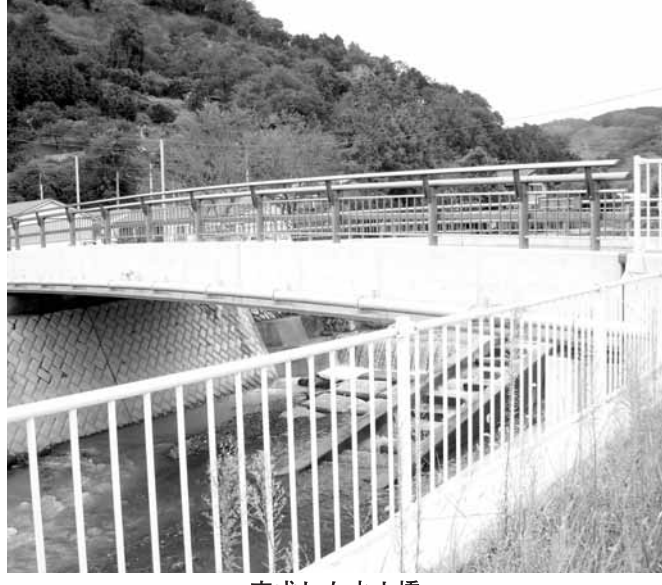
完成した水上橋
