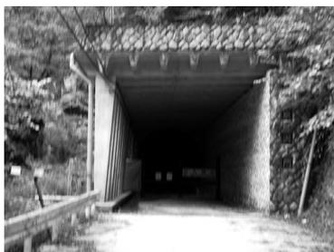
ひび割れで通行止めの青崩トンネル
