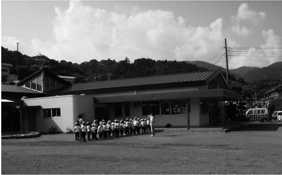
耐震工事が終了した山北幼稚園
