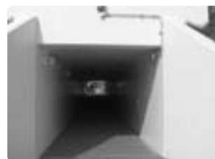
完成した東山北連絡通路 (人道BOX)
