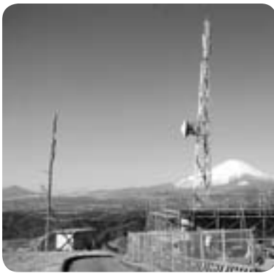
右側が地上デジタル放送局舎
