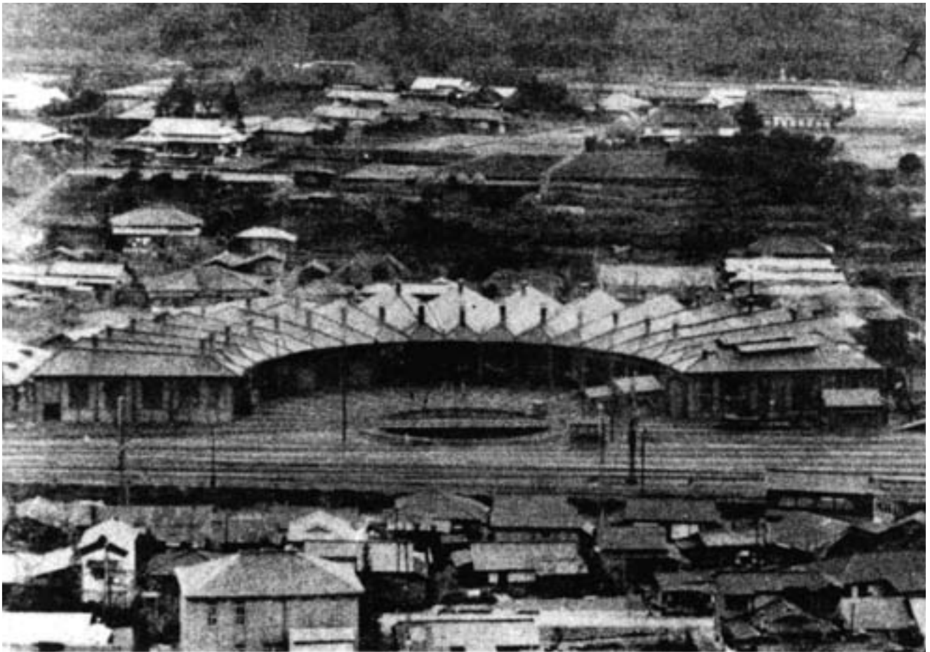
難所に備えた山北駅機関庫（現在の中央公民館付近）
